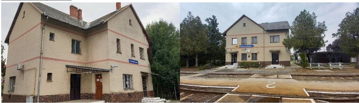
Saját fotók az épületről
